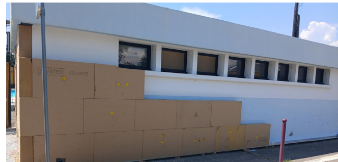
Réhabilitation de l'ancien snack de la piscine municipale
