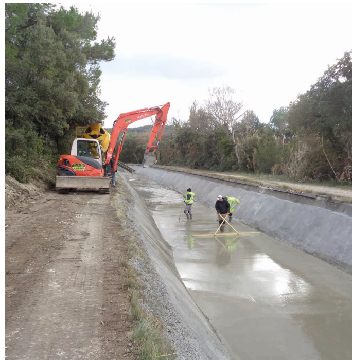
Des travaux de confortement avec bétonnage des berges sont réalisés chaque année sur les grands axes du canal.
