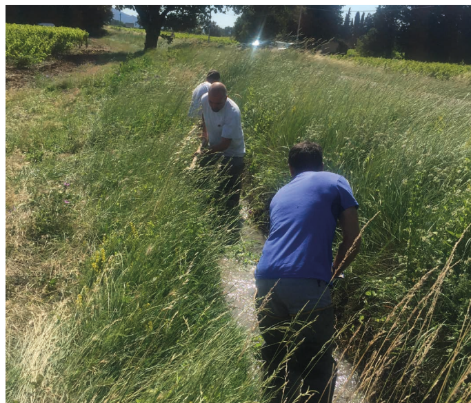
Des agents de terrain qui nettoient l'intérieur des filioles (petit canal d'irrigation) pour faciliter le passage de l'eau.
